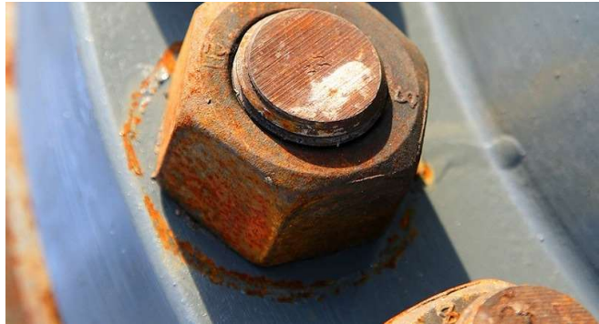
Exemplo de corrosão galvânica
